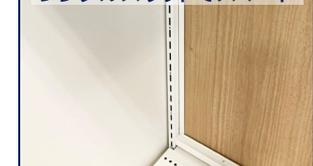
・通常70mmの柱のところ40mmの柱を使用
